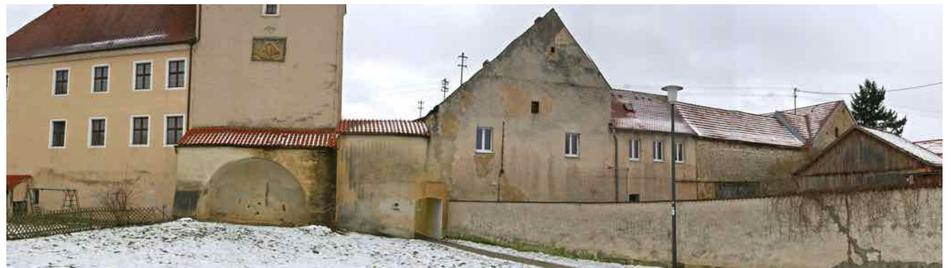
Ehemalige Stadtmauer mit Vilstor und wechselnden Funktionen: Außenwand Wohnhaus, Außenwand Stallgebäude
