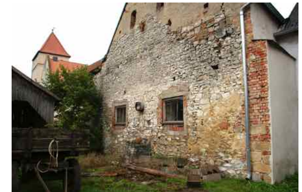
Stadtmauer als Außenwand Stallgebäude, Beispiel Herrengasse 9
