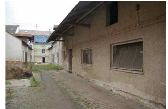
Hof und Nebengebäude Marktplatz 18, Blickrichtung südost, zu den Rückfassaden der Hauptgebäude
