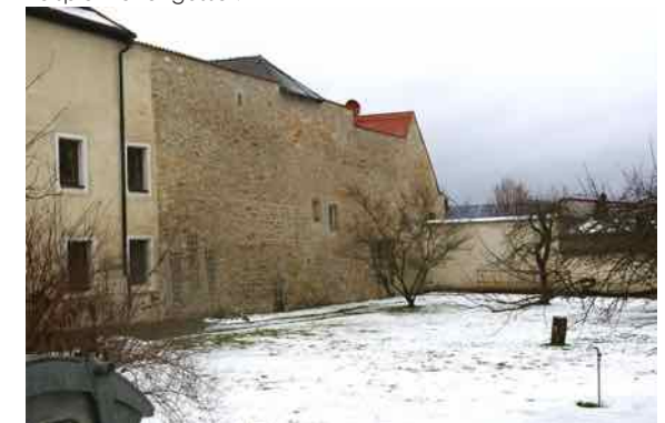
Stadtmauer als Außenwand Wohngebäude, Beispiel Klostersgasse 5, 7, 9
