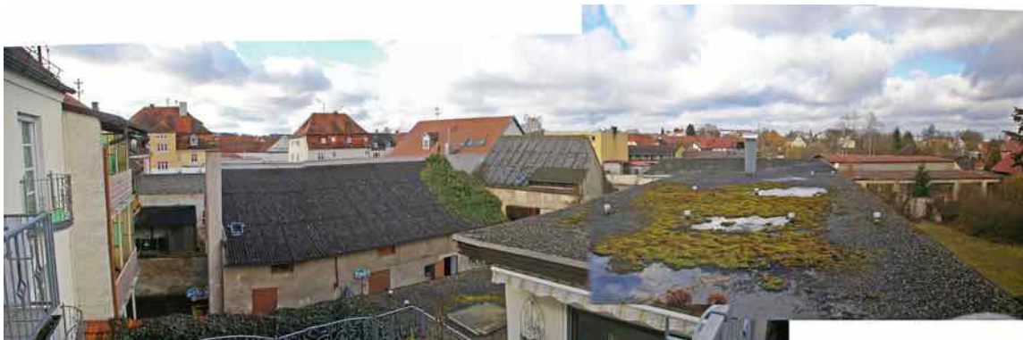
Blick von der Dachterrasse Marktplatz 26 in Richtung West (Bild links) und Ost (Bild rechts)
