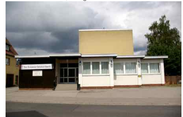
Vorfeld mit Wohn- und Gewerbegebäuden belegt hier Bahnhofstraße 8, Vordergebäude
