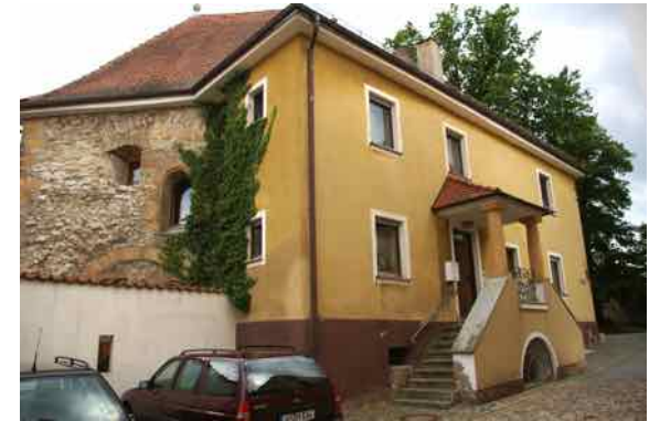
Stadtmauer als Teil des Wohngebäudes, Klostersgasse 11, Integration des ehemaligen „Oberen Tores“
