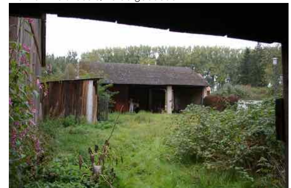
Vorfeld mit Lagergebäuden und Schuppen, überwiegend mindergenutzt
