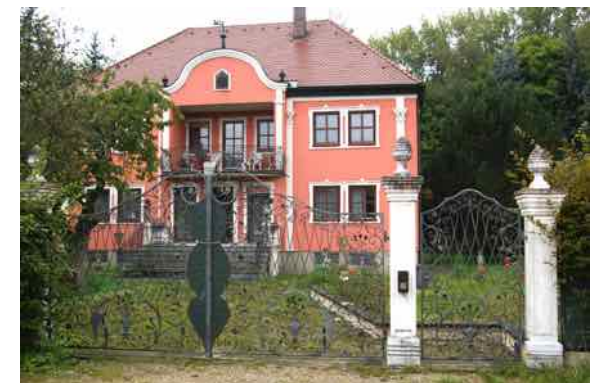
Wohngebäude Altmühlweg 4 im direkten Überschwemmungsbereich der Vils
