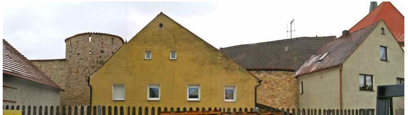
Erhaltener und rekonstruierter Stadtmauerbereich mit Bastionsturm auf Höhe Kirchgasse 12
