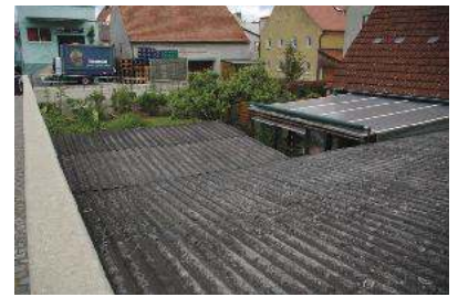
Beispiel: Dacheindeckung mit Zementfaserplatten in Vilseck
