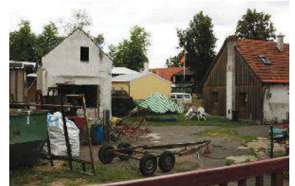
Baulich ungeordnete Situation am Ziegelanger
