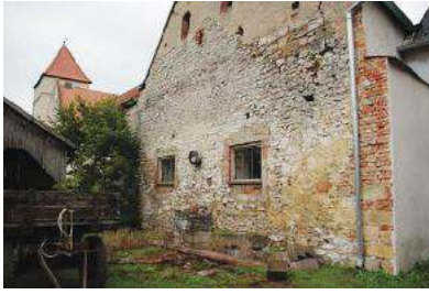
Wirtschaftsgebäude in der Herrengasse, Wand mit Stadtmauerresten
