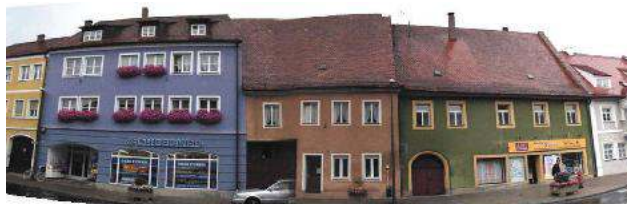
Fassaden Marktplatz Nr. 22-26
