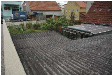
Beispiel: Deckung mit Faserzementplatten, Grabenstraße 11
