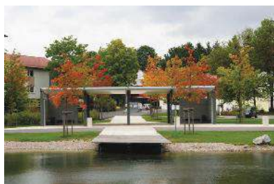
Grund- und Hauptschule Vilseck mit neuer Eingangssituation am Schnellweiher
